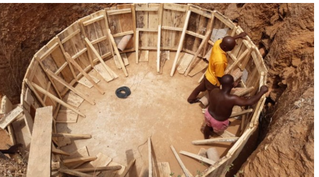
Verschalen des Biogas-Doms
